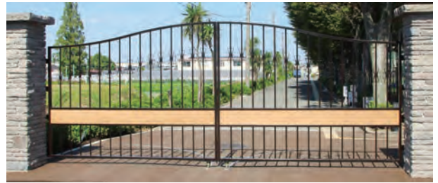
図23 正門は丹波鉄平の門柱、装飾を施したオリジナルデザインの鉄扉、鉄扉に織り込んだ厚さ40mmのオークの厚板で構成されている。こうした自然素材は、動物の丘、正門手前の小庭とともに、これらが農芸の技であることを日々通う在校生に感じてもらうことになる。
