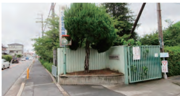
図3 正門までが短いため、開錠のため停車した車両が歩道にはみでる。
