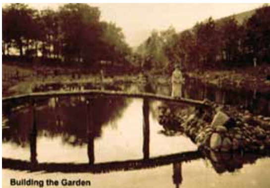
写真-13 池中島にかかる反橋(木橋)
