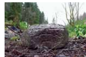
写真-48 基礎側面厚さ190mm
