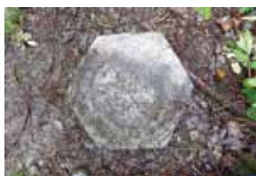
写真-47 基礎上部直径450mm
