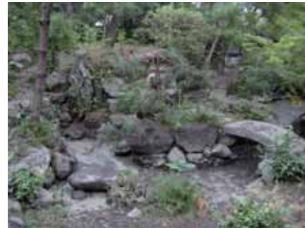
写真-15 浚渫工事完了
