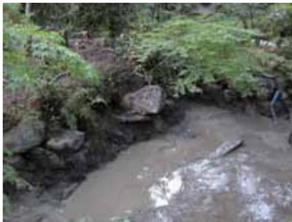
写真-13 浚渫工事
