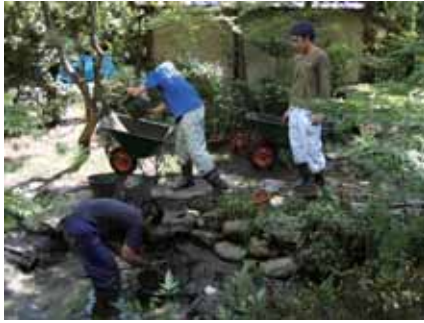
写真-12 浚渫工事
