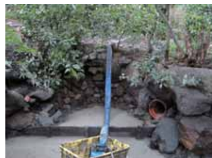
写真-18 浚渫工事完了
