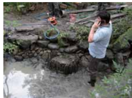
写真-17 浚渫工事完了
