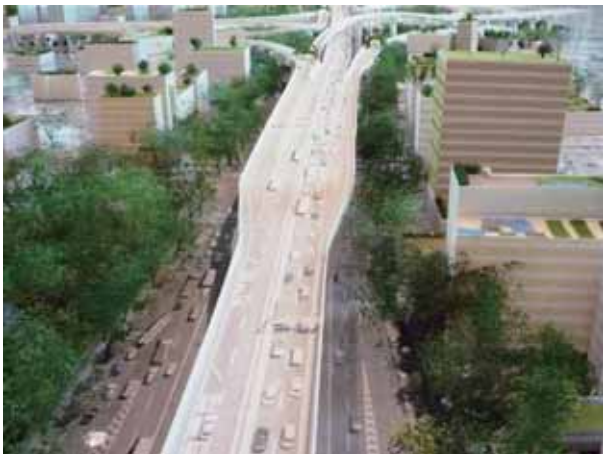
写真3. 国道308号線沿線の緑地帯
