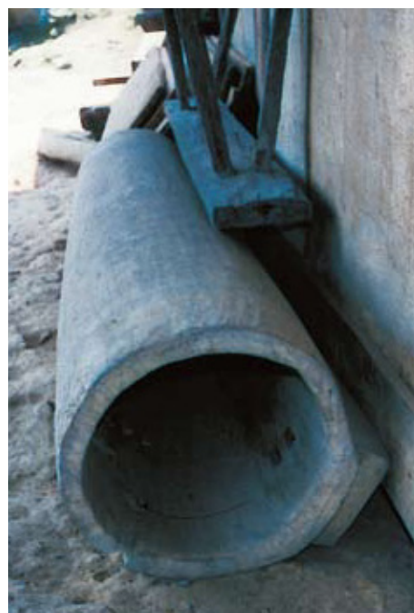
写真13 ザオの住居用の建材 移動先への運搬が考慮され、刳り貫かれた円柱
