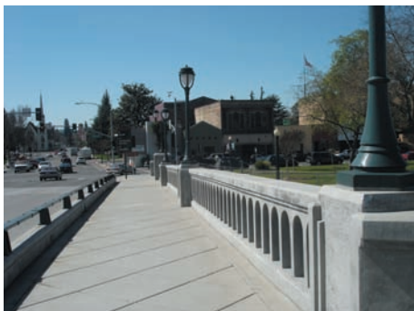
写真7 完成した Third Street 橋
