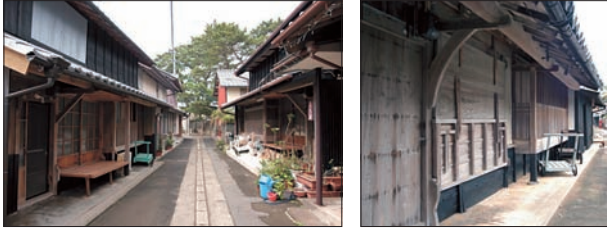
出羽島のぶっちょう造り
