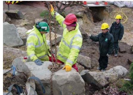
写真-10 石組工事
