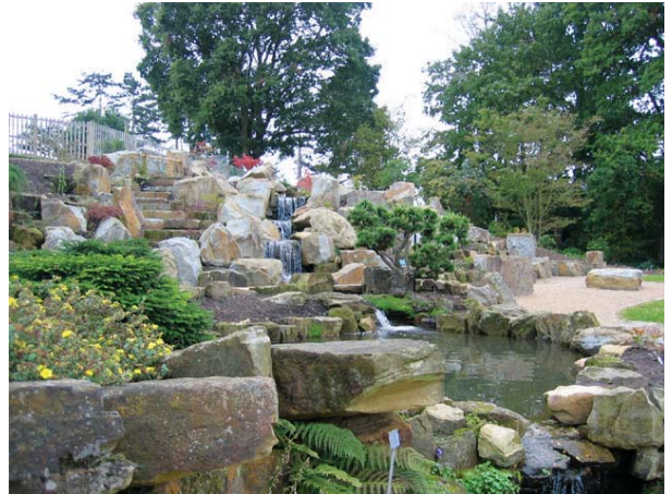
写真-12 植栽工事
