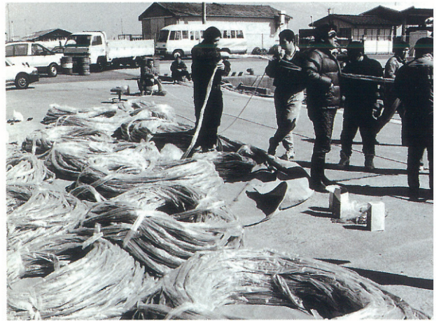
図2 地平線プロジェクトの準備風景 防水対策としてビニールに巻かれた導火線
