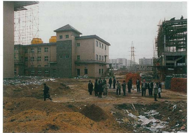
写真-2 中庭現況 98.3
