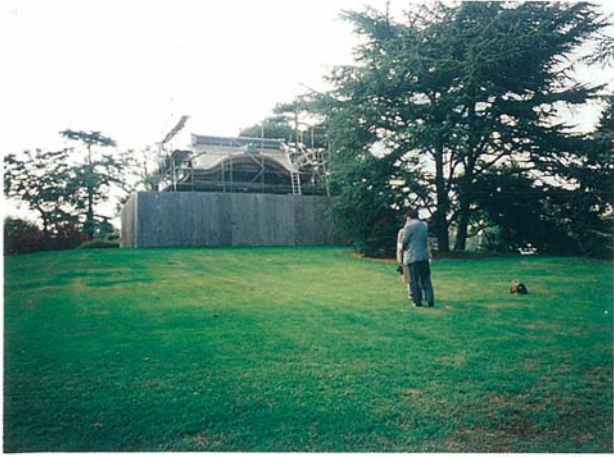
写真-1 勅使門北側の現況
