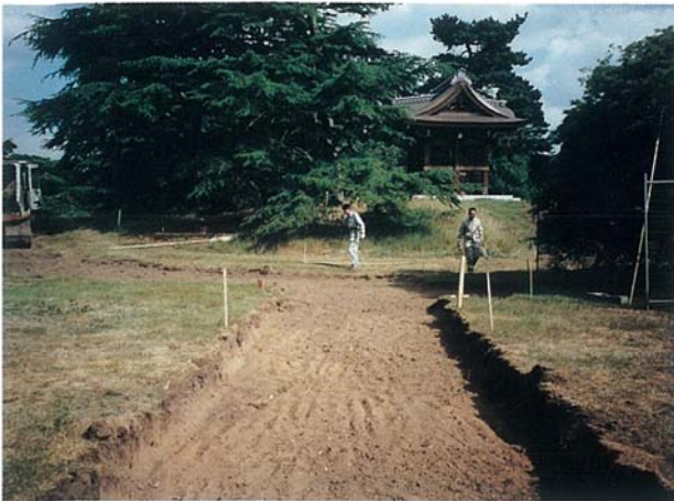
写真-5 「静寂の庭」入口の造成
