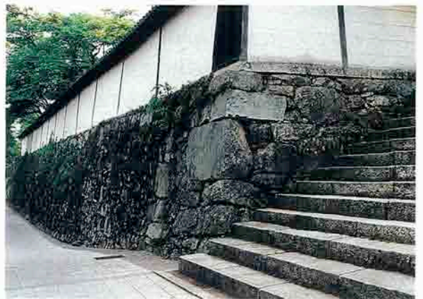
(写真-8) 滋賀院 石垣
