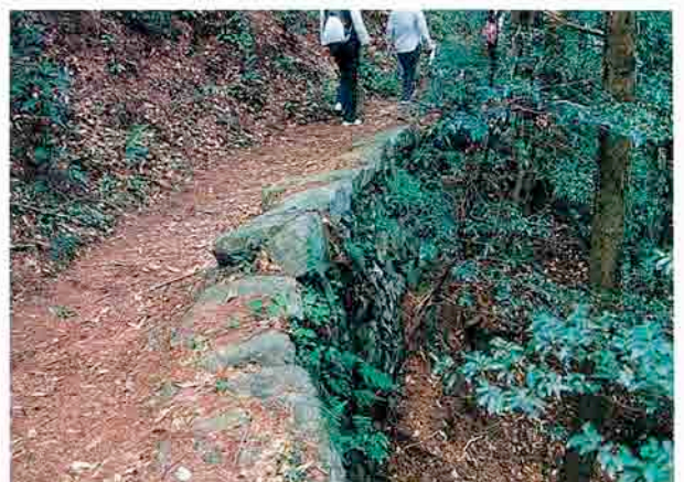
(写真-4) 無動寺坂の土留石垣
