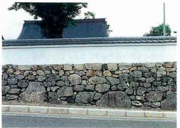
(写真-9) 生源寺 石垣
