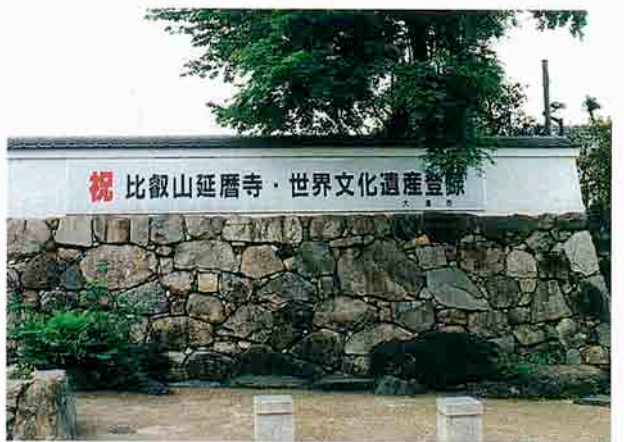
(写真-15) 築後7年を経た京阪坂本駅前の石垣
