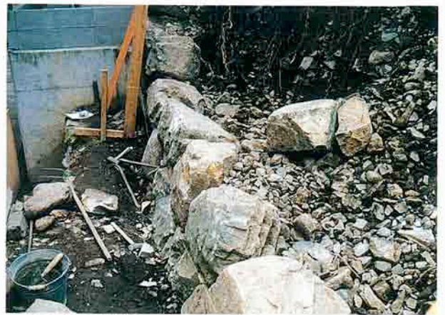
(写真-14) 石垣構築中 裏込栗石を充填する
