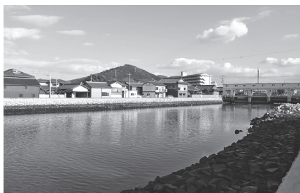
(写真4) 大東川の南東を見る。右奥に水門。
