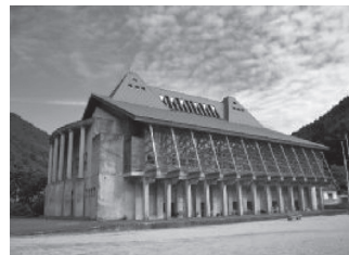
写真5：龍神村体育館全景
